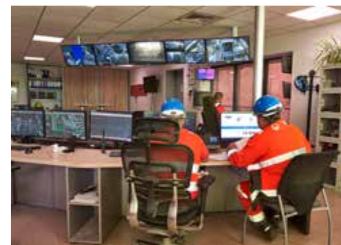
Salle de commandes et de supervision du CMVD d'Échillais.
